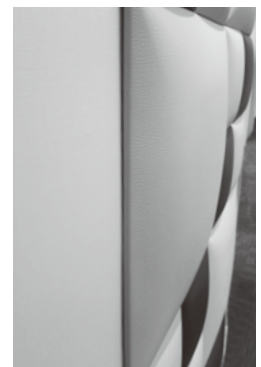
▲両面テープ施工
