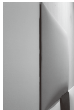
▲マジックテープ施工
